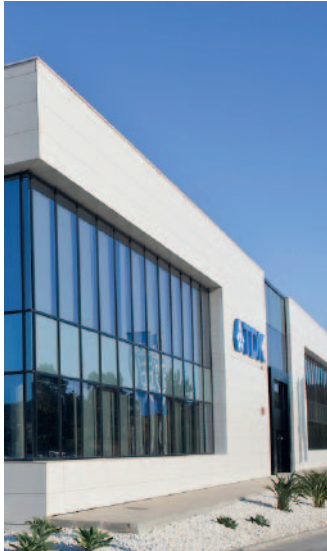
Завод в Малаге (Испания)
